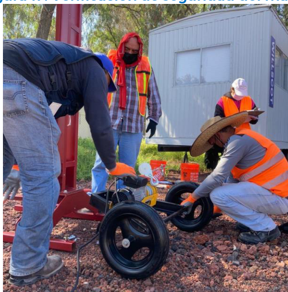
Figura 18. Armado del mástil, base y malacate.
