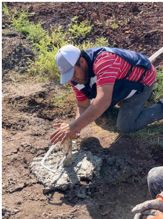
Figura 34. Corte de la tubería de PVC sobre la última lechada de cemento antes de colocar el contra ademe.
