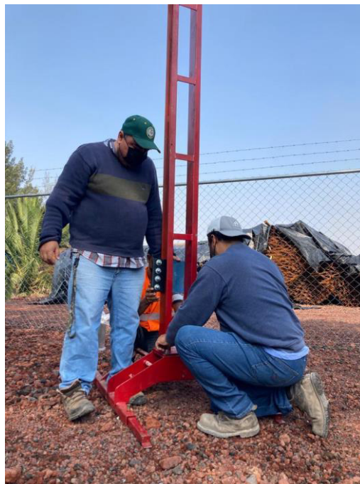
Figura 3. Ensamble del soporte y el mástil en campo.
