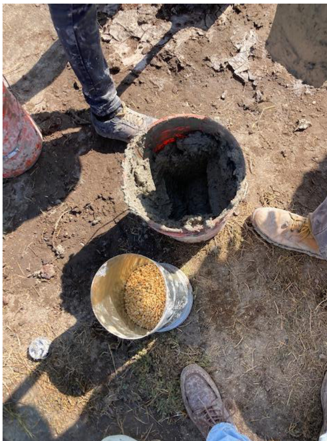
Figura 32. Preparación del cemento y gravilla para el proceso de cementado.
