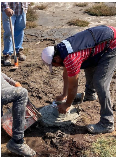
Figura 35. Colocación de la nucleadora como contra ademe en el piezómetro.
