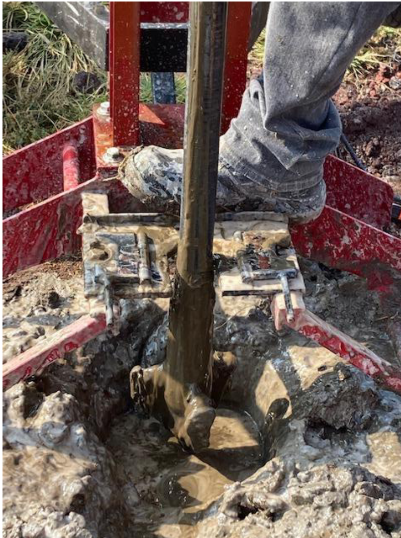
Figura 27. Retiro de la sarta de perforación, dejando las condiciones de agujero descubierto.
