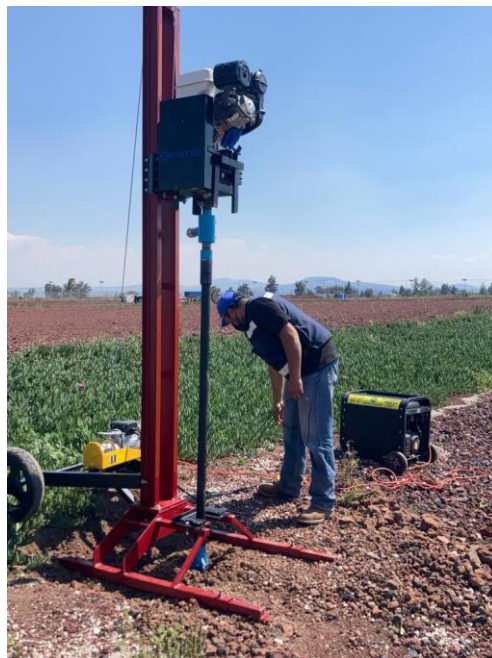
Figura 21. Preparación del malacate y planta de luz al equipo de perforación.
