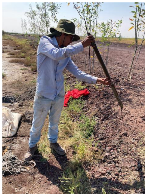
Figura 33. Limpieza del interior del tubo de PVC con equipo bailer. A) introducción del bailer dentro del tubo de PVC. B) Extracción del lodo de perforación.
