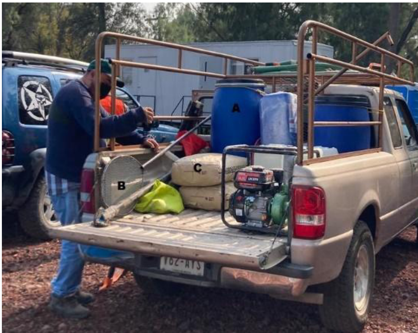
Figura 14. Material necesario para la construcción de piezómetros. A) Bidones de agua, B) Red pescadora, C) Sacos de grava.
