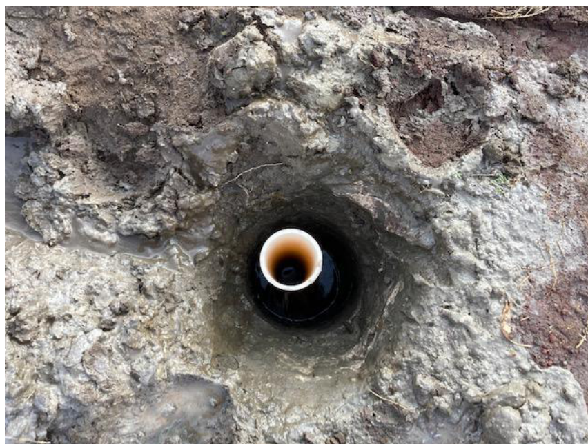
Figura 30. Tubería de PVC completamente hincada
