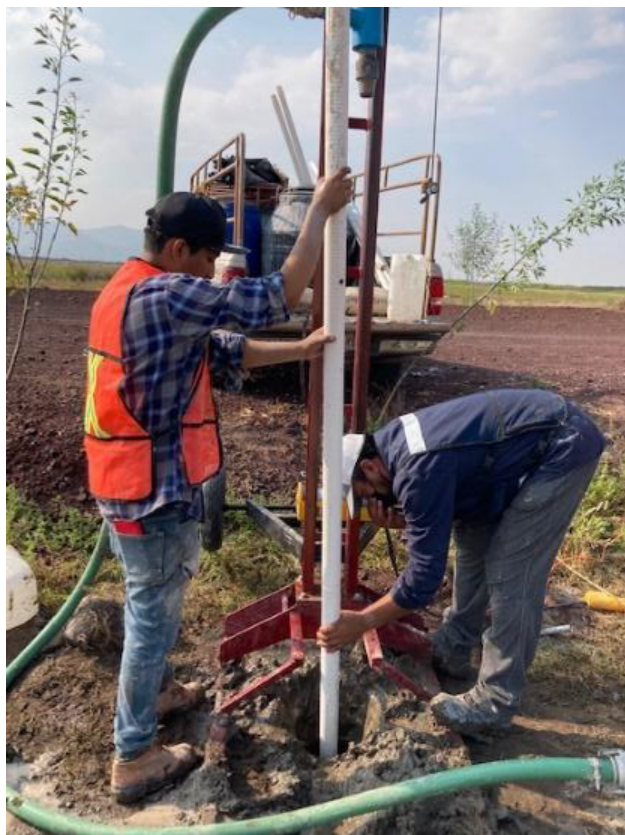
Figura 29. Proceso de hincado del piezómetro
