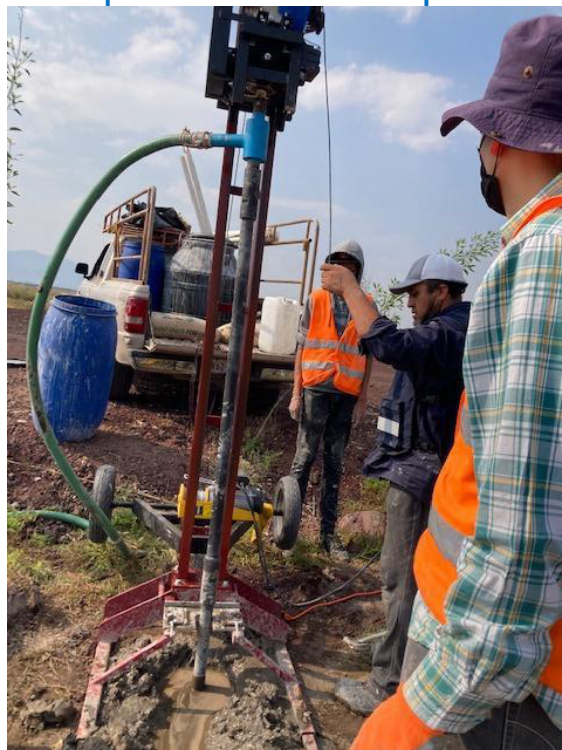
Figura 26. Lubricación con lodo de perforación del agujero del piezómetro.
