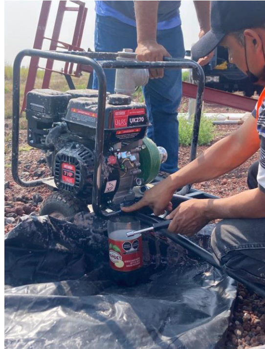
Figura 8. Mantenimiento de la Motobomba previo a la perforación de un pozo para la instalación de un piezómetro.
