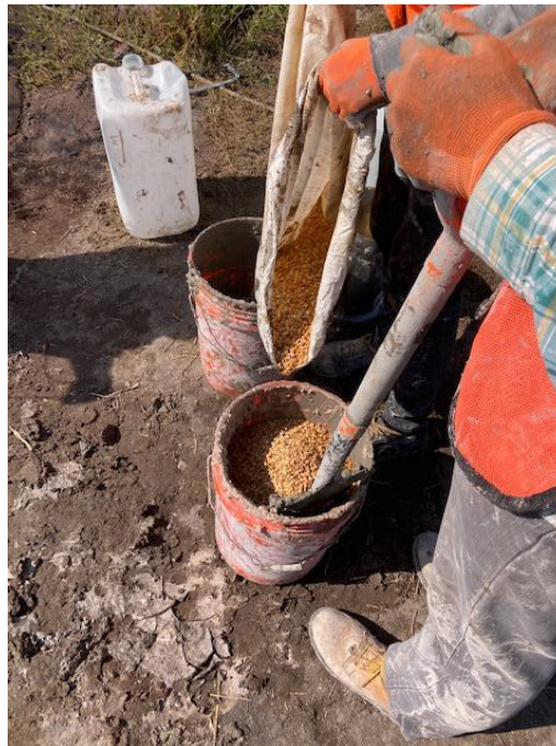
Figura 31. Preparación de la arena sílica antes de introducirla alrededor de la perforación.
