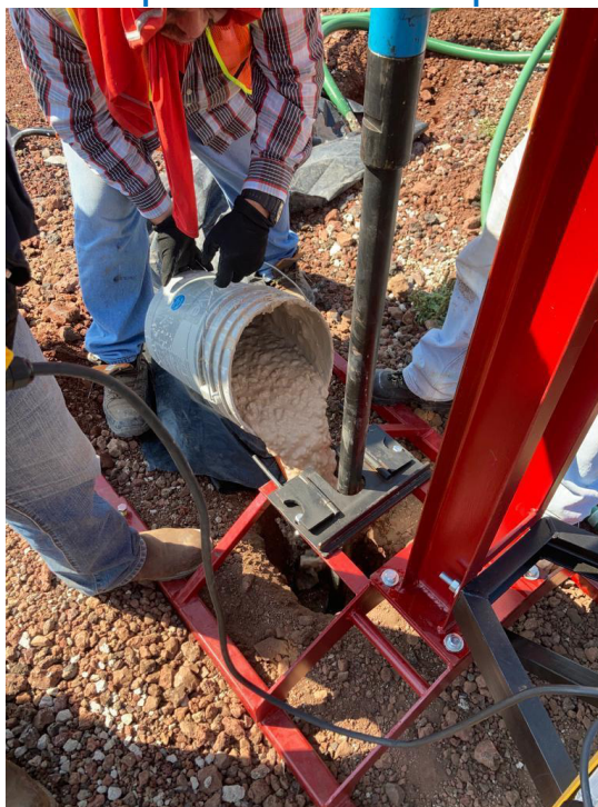
Figura 24. Ingreso de la primera lechada de lodo bentonítico colocada manualmente previo al inicio de la perforación.
