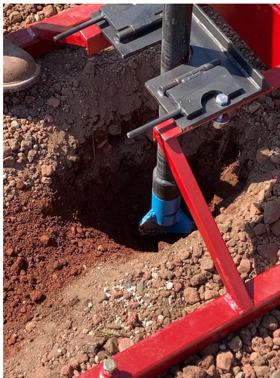
Figura 23. Preparación de la barrena y la cuña alrededor de la tubería de perforación previo al inicio de la perforación.
