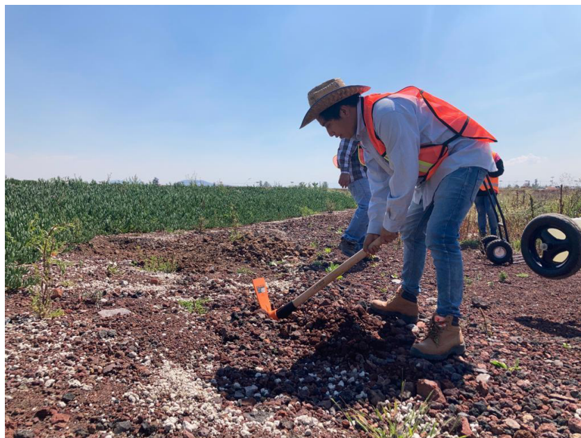
Figura 19. Preparación del sitio, previo a al montaje del equipo de perforación.
