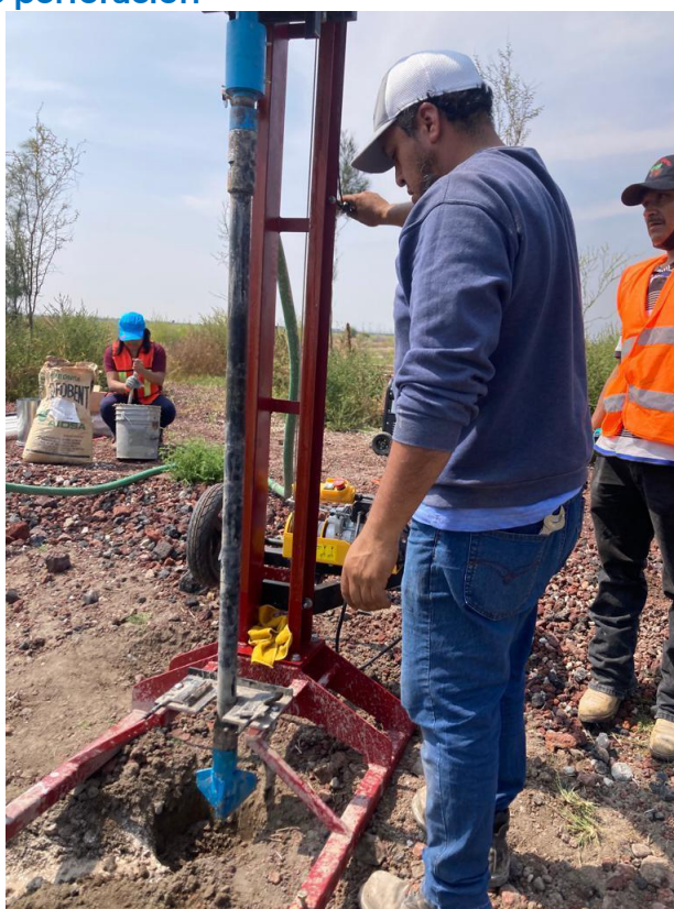
Figura 12. Barrena instalada en el equipo para iniciar la perforación.
