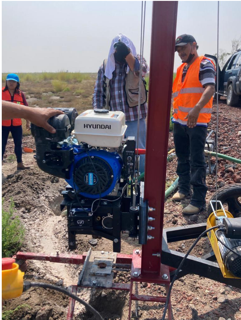
Figura 6. Motor de perforación montado sobre el mástil y el malacate conectado.
