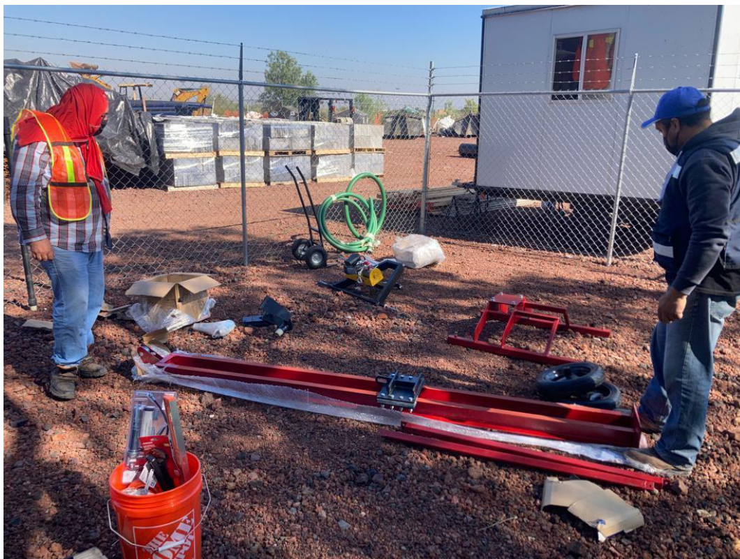
Figura 17. Verificación de seguridad del mástil.
