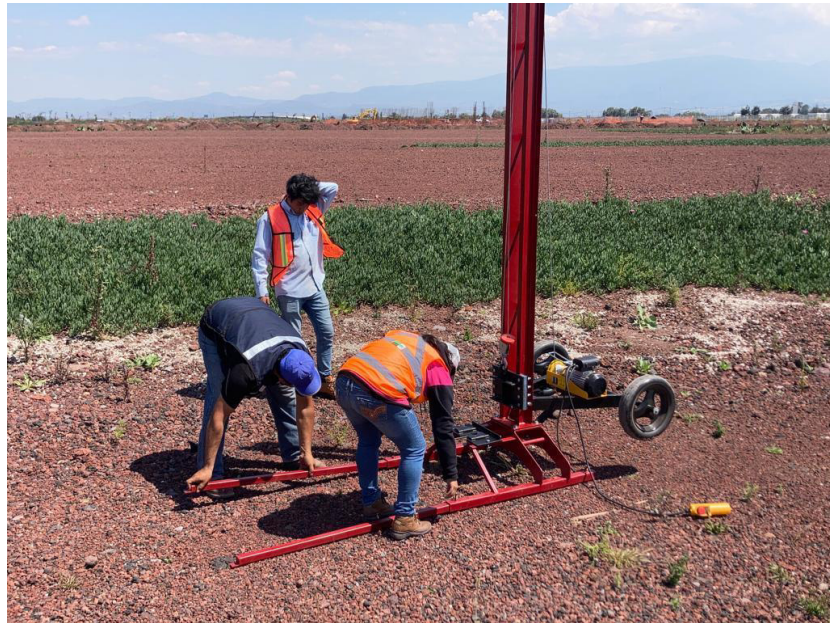
Figura 20. Levantamiento del equipo de perforación en el sitio preparado.
