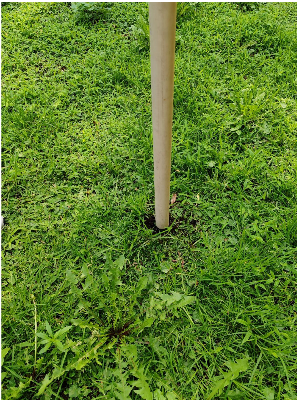
Figura 24. Hincado de tubería
