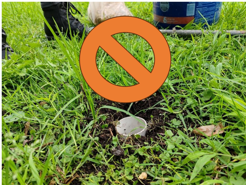
Figura 25. No se debe hincar por completo la tubería.
