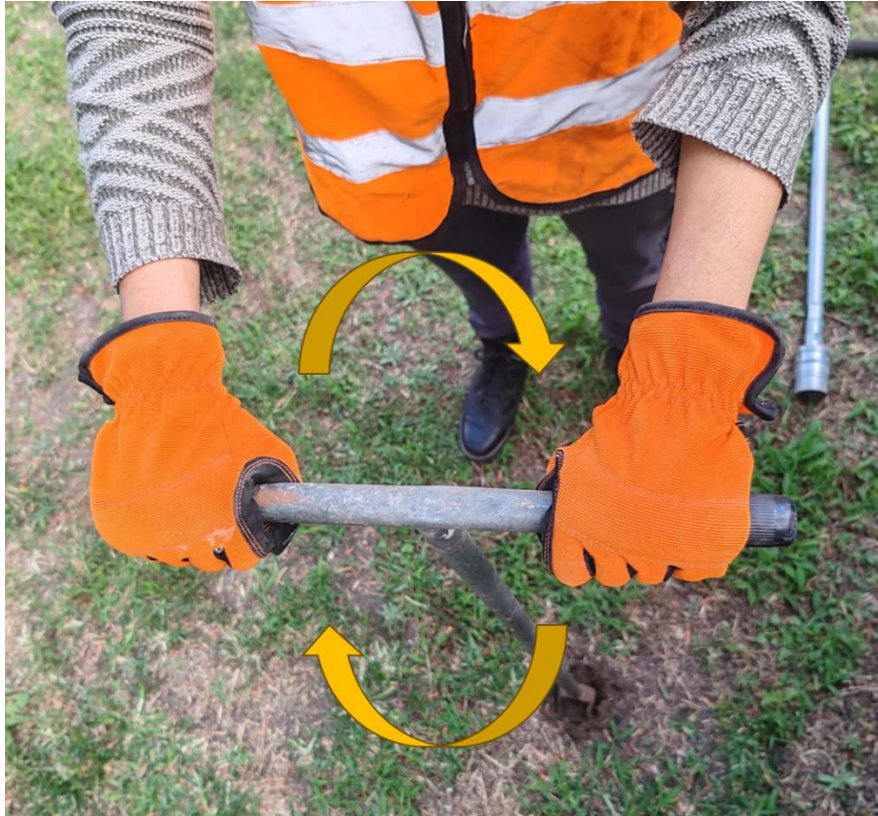
Figura 15. Ejemplo del sentido de giro al perforar un agujero con barrenas.
