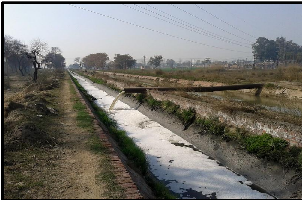
Fig. 31 Desagüe de aguas residuales en canal abierto de Punjab, India. Recuperado de: www.flickr.com
