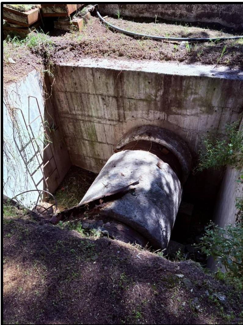
Fig. 67 Acueducto del Sistema Lerma 2 en Temoaya, México. Autor: Gonzalo Hatch Kuri.
